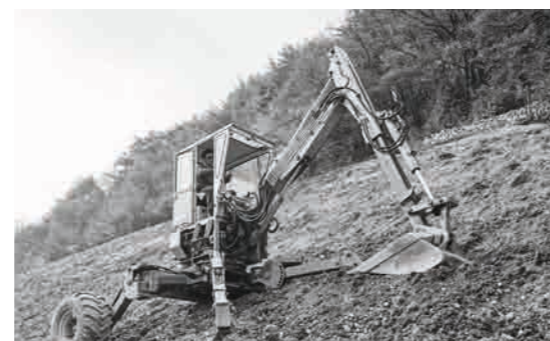
Terrassierung mit Einsatz des Baggers.
